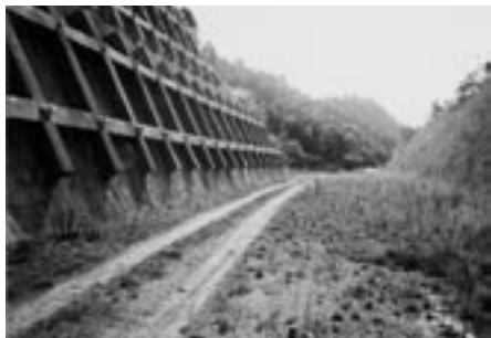
工事中の広域農道南端
