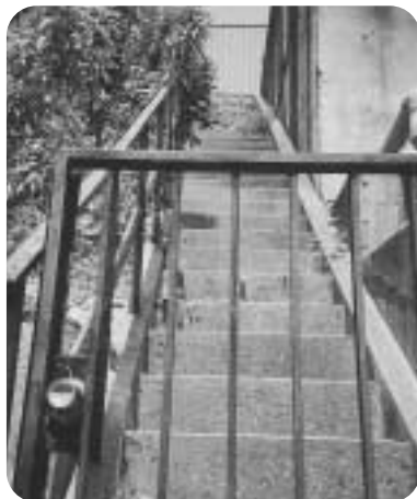
階 段 純粋に階段としてのみ存在する階段!?
