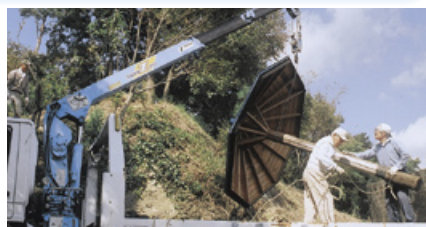
展望所にアンブレラ搬入、大変苦労した作業でした
