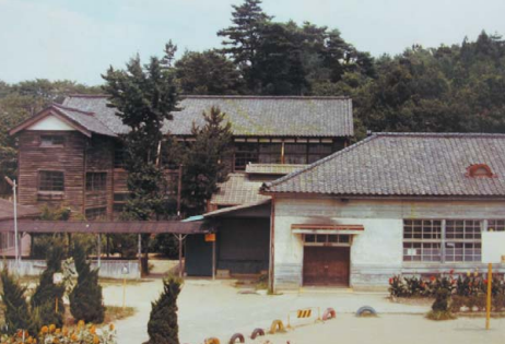
2階建校舎（写真奥） 昭和22年～28年まで中学校舎として使用、 それ以降は小学校の音楽室として使用された
