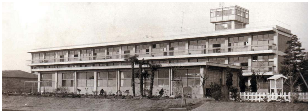
昭和38年頃 当時としては斬新なデザインの教室棟(南側が通路)
