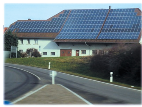
民家の太陽光パネル
