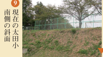
9 現在の太田小 南側の斜面
