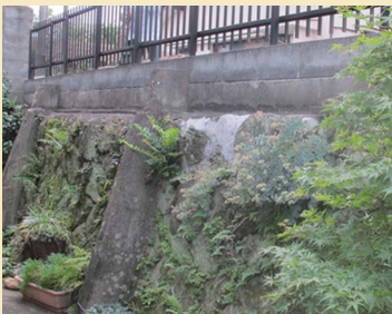
6 太田御殿の正門があったと云えられている付近の石積跡？
