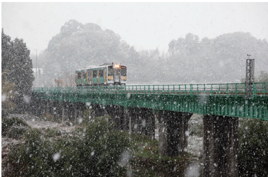
萩庭さん撮影の水郡線久慈川鉄橋
